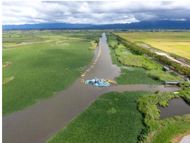
福島潟における当社独自の工法を用いた浚渫工
